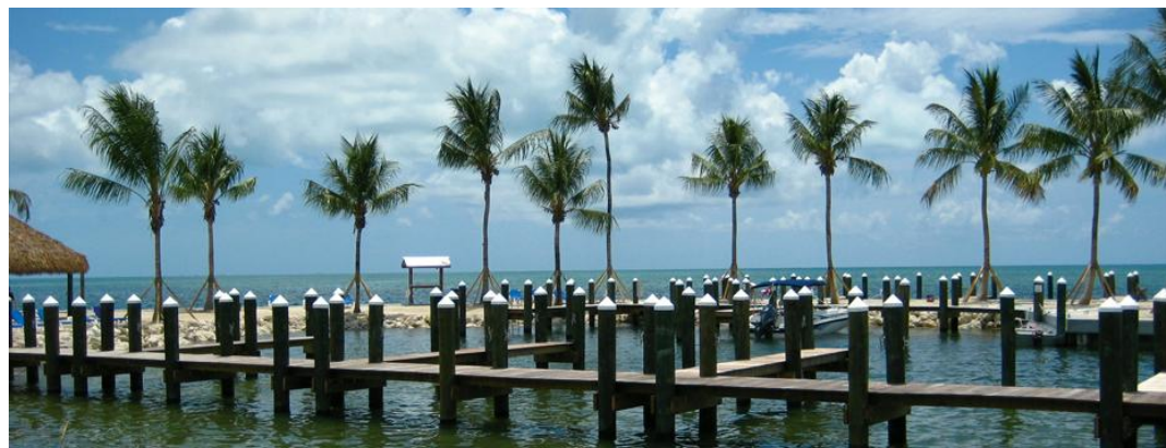
Figura a20.5: Porto de recreio em Key Largo, Florida Fonte: http://shorelinefoundation.com/projects/marinas-resorts .
