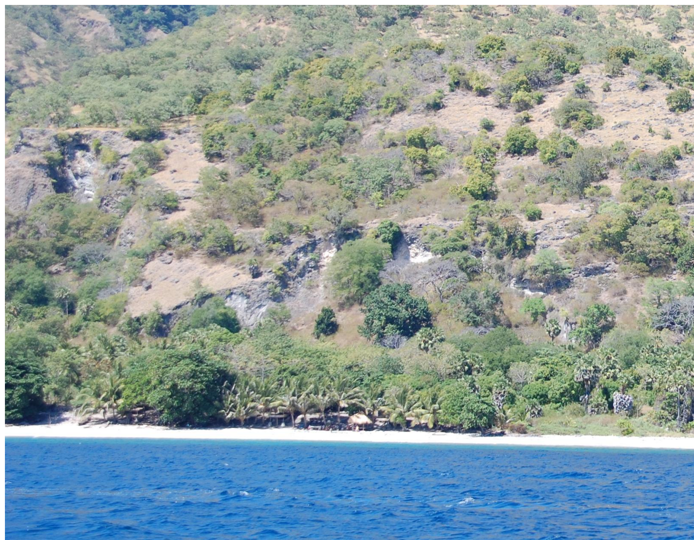
Figura a3.1. Vista de uma vertente geológica de risco, localizada em Adara, com perigo de queda de blocos e de deslizamento de terras sobre zonas habitacionais da comunidade.
