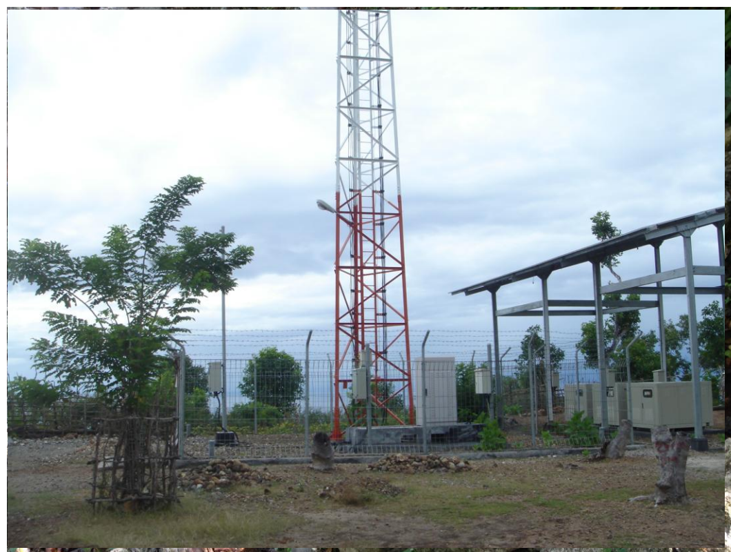
Figura a46.1: vista de uma antena de transmissão de sinal de móvel. Suco Vila-Maumeta Fonte: Dalan, 2015
