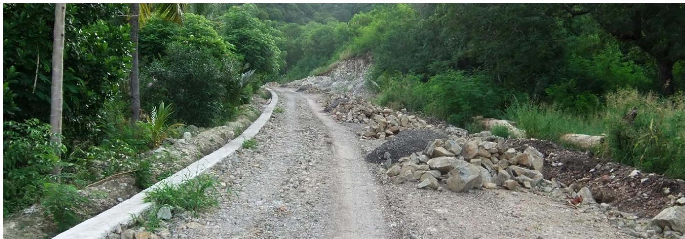
Figura 3 – Dificuldade de acessos. Necessidade de investimento em infraestruturas de acessibilidade. Fonte: Dalan,2015.
