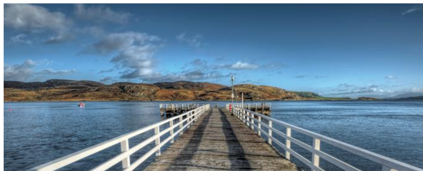
Figura. a10.2 – Vista superior de uma ponte-cais de madeira (Fonte: https://500px.com/photo/51605020/tighnabruaich-pier-by-kevin-perkins )
