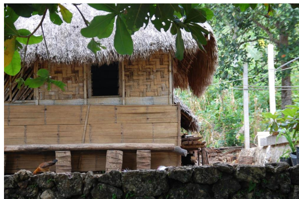
Figura a22.1 – construção tradicional em palapa e colmo de Ataúro Fonte: Dalan, 2015
