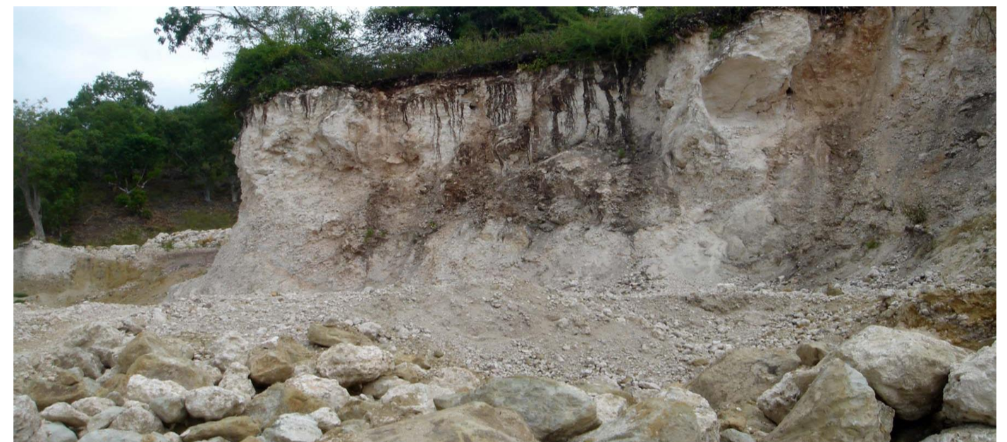
Figura a33.3: actividade de extracção não controlada. Suco Vila-Maumeta
