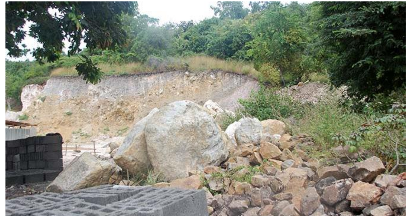
Figura a33.2: actividade de extracção não controlada. Suco Vila-Maumeta
