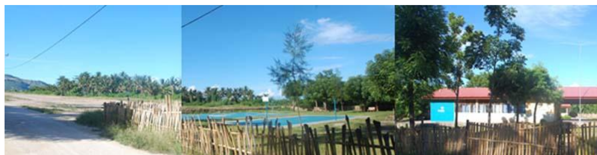
Figura a18.3: Vistas da escola no fim da pista. Aldeia de Raikete.
